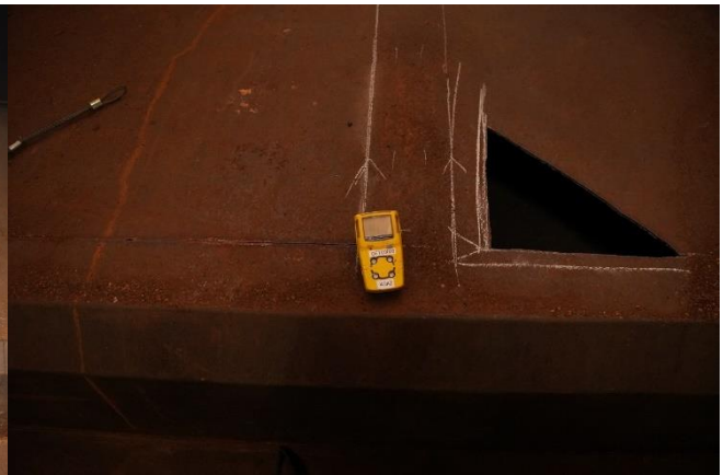
Figure 9 : caisson n° 20, détail de la découpe
