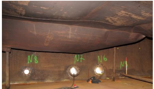
Figure 2 : Déformation de l'écran flottant vue du dessous
