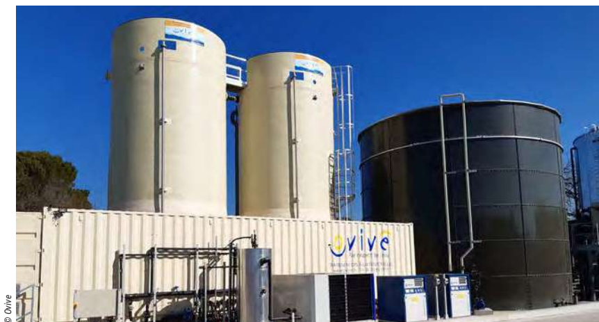
Ovive a réalisé environ 150 installations industrielles (ici, une cuve en acier vitrifié) depuis sa création. Si les principaux secteurs sont le pharmaceutique, l'agroalimentaire et la cartonnerie, le BRM a aussi sa place dans des process industriels particuliers.
