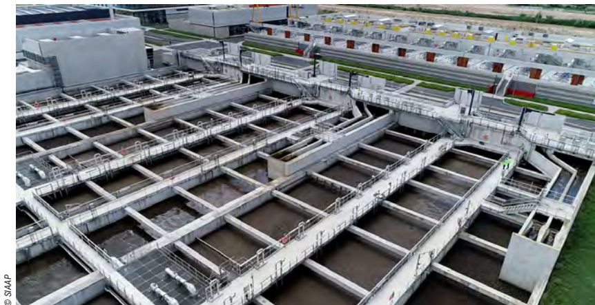
Le parc membranaire de l'usine Seine Aval du SIAAP dispose d'une surface filtrante de 462 000 m 2 .
