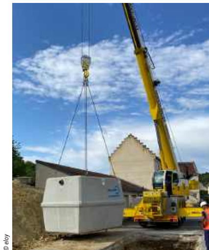
Une microstation oxyfix 100 EH d'eloy est en cours d'installation pour un lotissement dans le Vaucluse.
