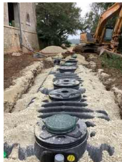
Sur ce chantier, une filière compacte Actifiltre185 de Rikutec est ici installée pour de grands volumes jusqu'à 40 équivalents-habitants (EH).
