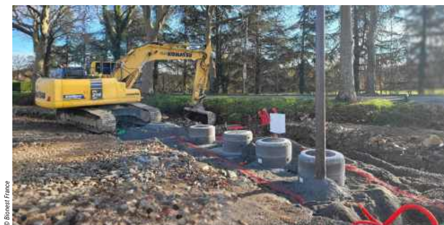
Un système d'assainissement non collectif de Bionest est mis en place dans un lotissement du Sud-Ouest de la France.
