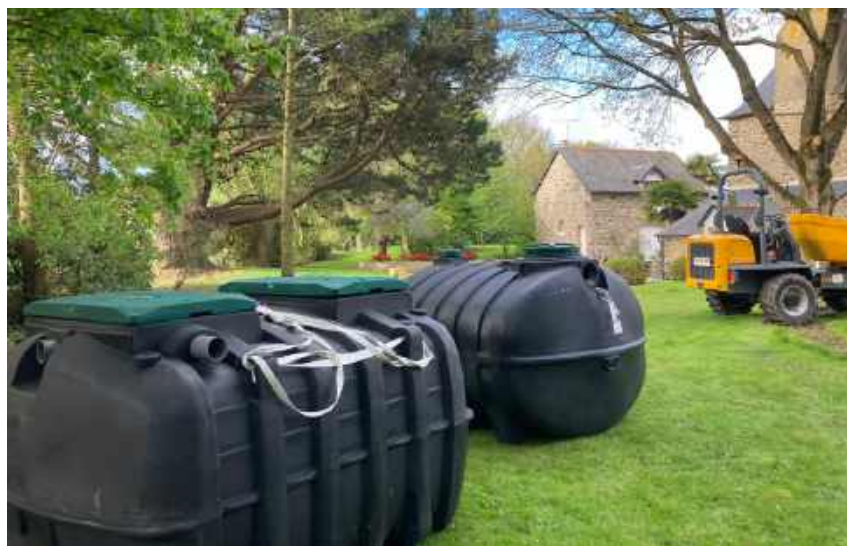
Une filière agréée Bionut d'une capacité de 8 équivalents-habitants (EH) de Simop France va être enterrée dans une propriété à Saint-Malo.
